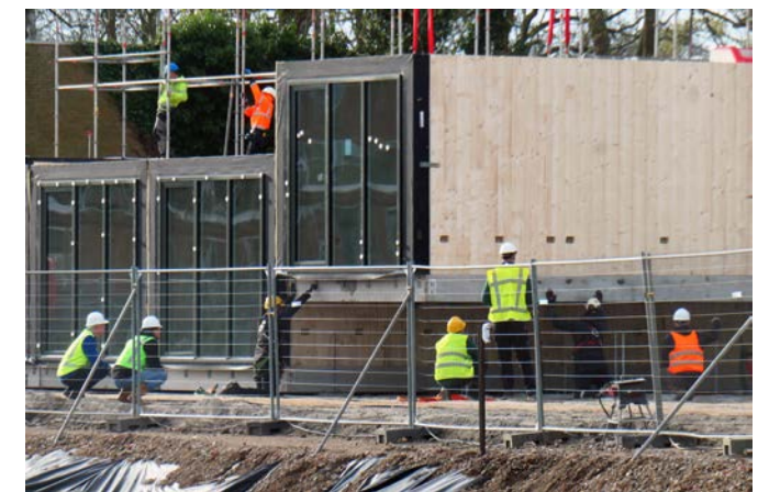
Plaatsen van de modules.
